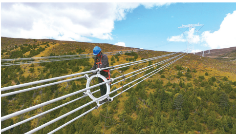
电力工人在金沙至湖北特高压工程川西段安装间隔棒(张月 摄)
