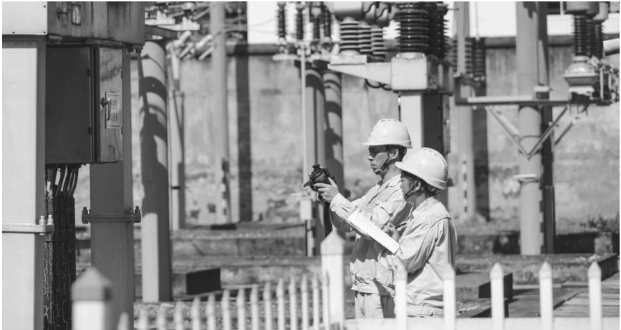
供电公司员工巡检变电设备（张建 摄）
