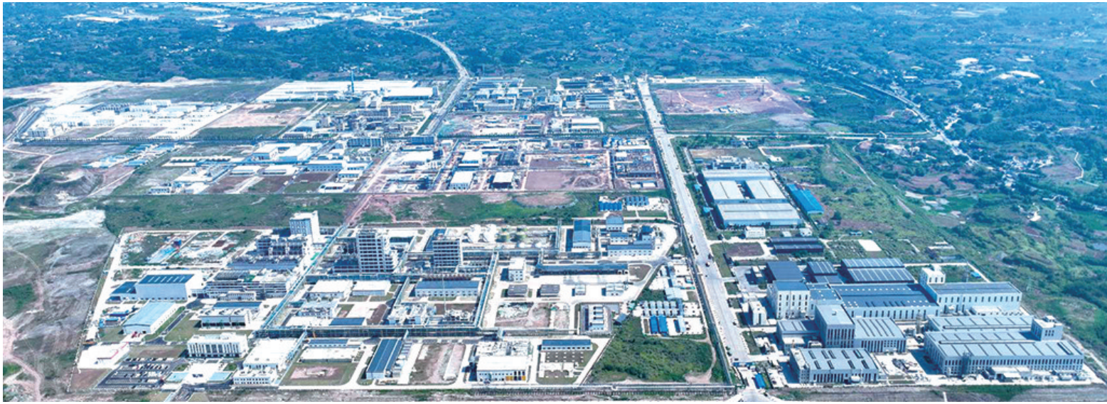
自贡川南新材料化工园区 (中共自贡市沿滩区委宣传部供图)
