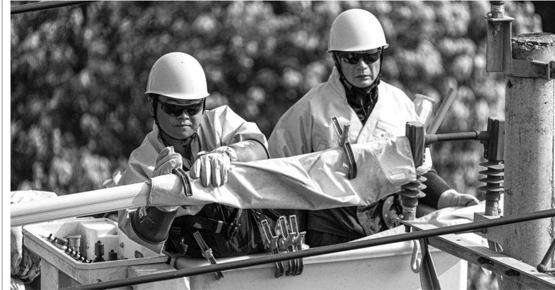
国网绵阳供电公司带电作业中心员工头顶烈日,对位于涪城区塘汛镇的10千伏塘汛二线进行带电搭火作业(田海摄)
