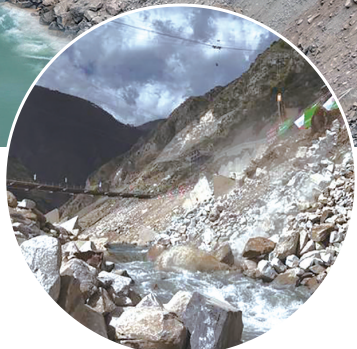
孟底沟水电站数十辆新能源自卸车将石料倾倒入龙口 (新华社发)
