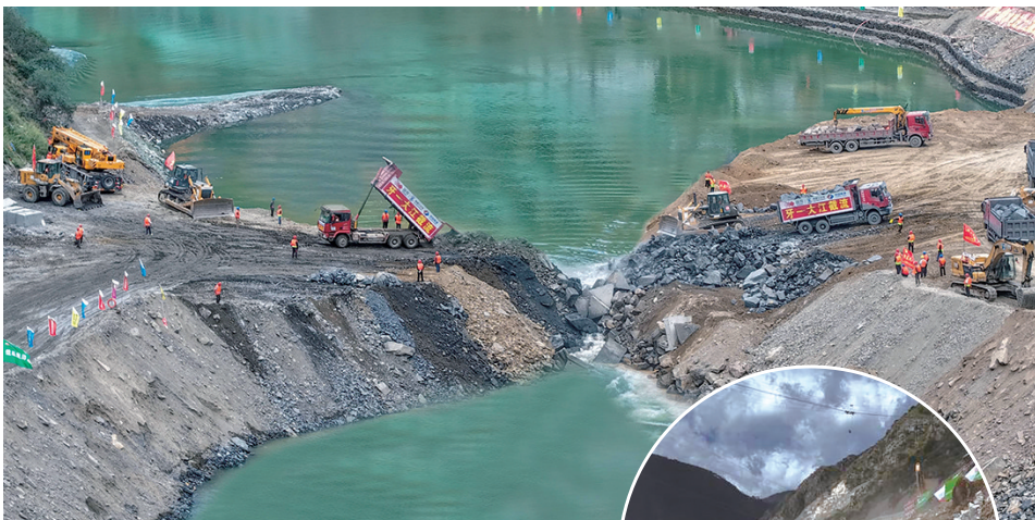
牙根一级水电站龙口合龙即将成功,数十辆自卸汽车来回不间断运输石料进行填筑 (新华社发)
