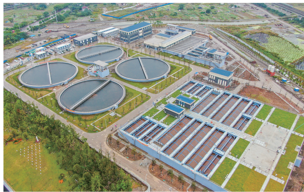
松江污水处理厂四期改扩建工程扩建部分基本完工,10月初已开始联机通水调试。 记者 蔡斌 摄
