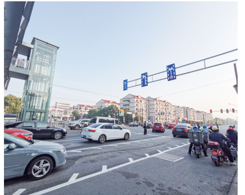
图为12月7日早高峰期间,车辆经可变车道有序通过路口。 记者 陈菲茜 摄
