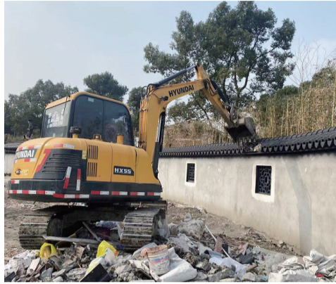
昨天上午,违法搭建部分开始拆除。 记者 张立 摄
