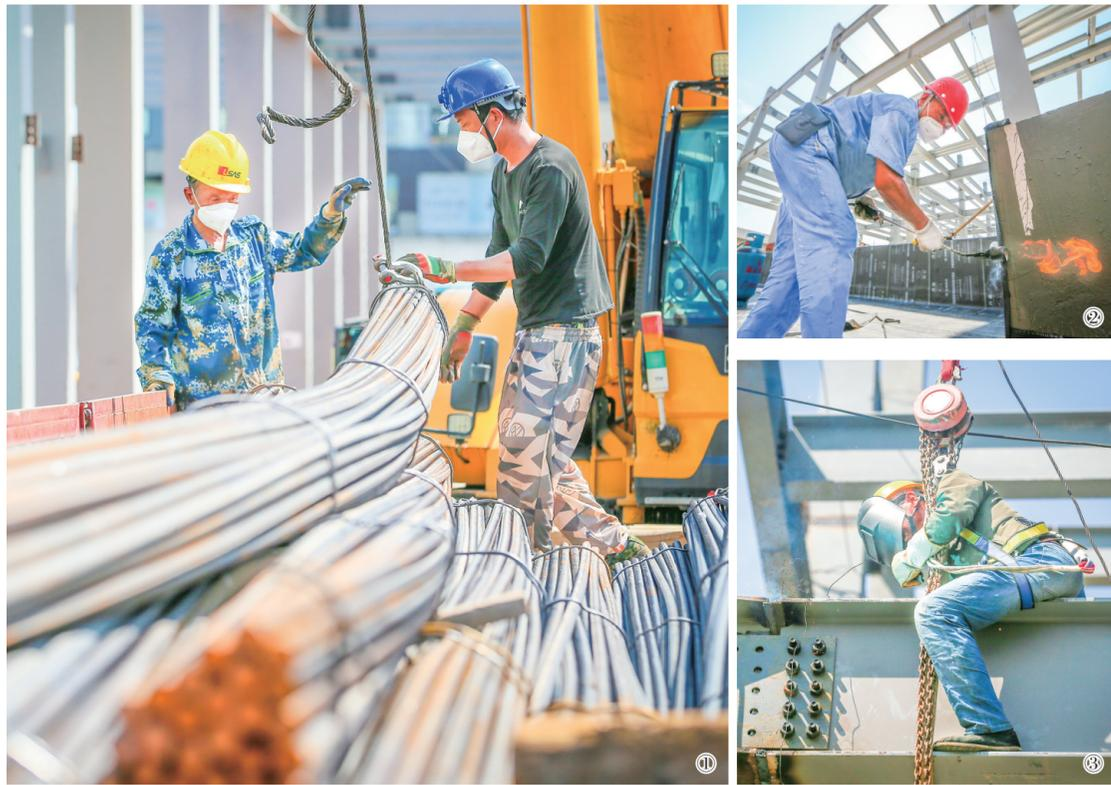
烈日下,空气灼热,钢筋滚烫。上海宝鸟服饰有限公司翻建生产用房项目工地上,建设者们奋战施工一线。图①为工人正在起吊钢筋;图②为工人正在对防水层进行加热密封处理;图③为钢梁焊接施工现场。
