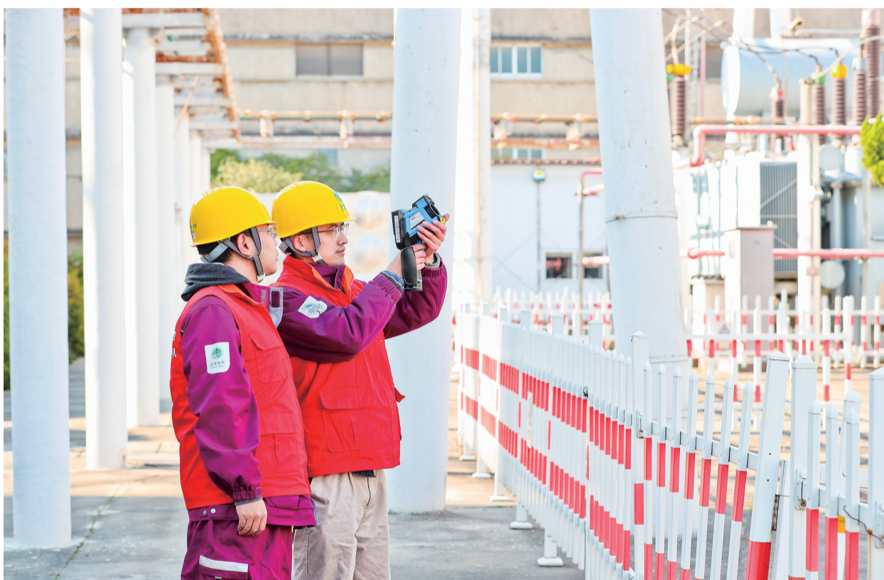
寒潮期间,松江供电公司员工检查线路,确保安全用电。
