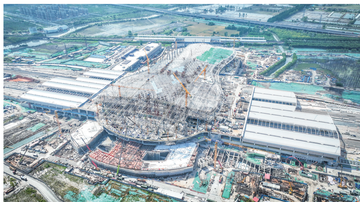
图为建设中的松江枢纽。
