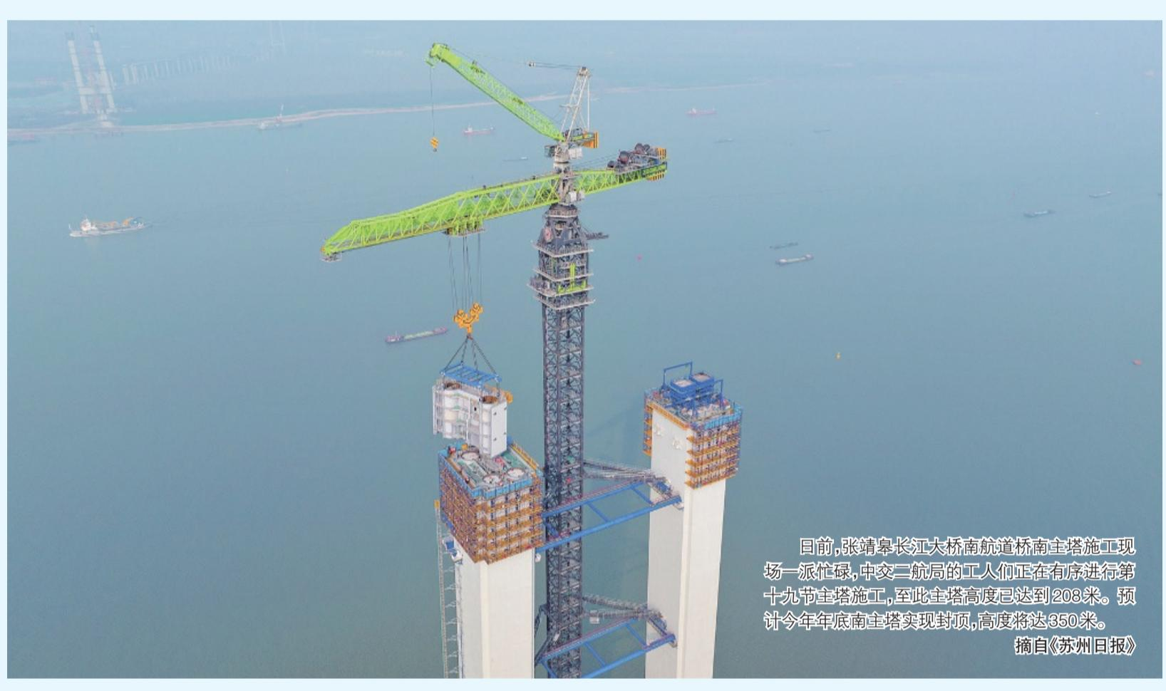
目前，张靖皋长江大桥南航道桥南主塔施工现场一派忙碌，中交二航局的工人们正在有序进行第十九节主塔施工，至此主塔高度已达到208米。预计今年年底南主塔实现封顶，高度将达350米。
