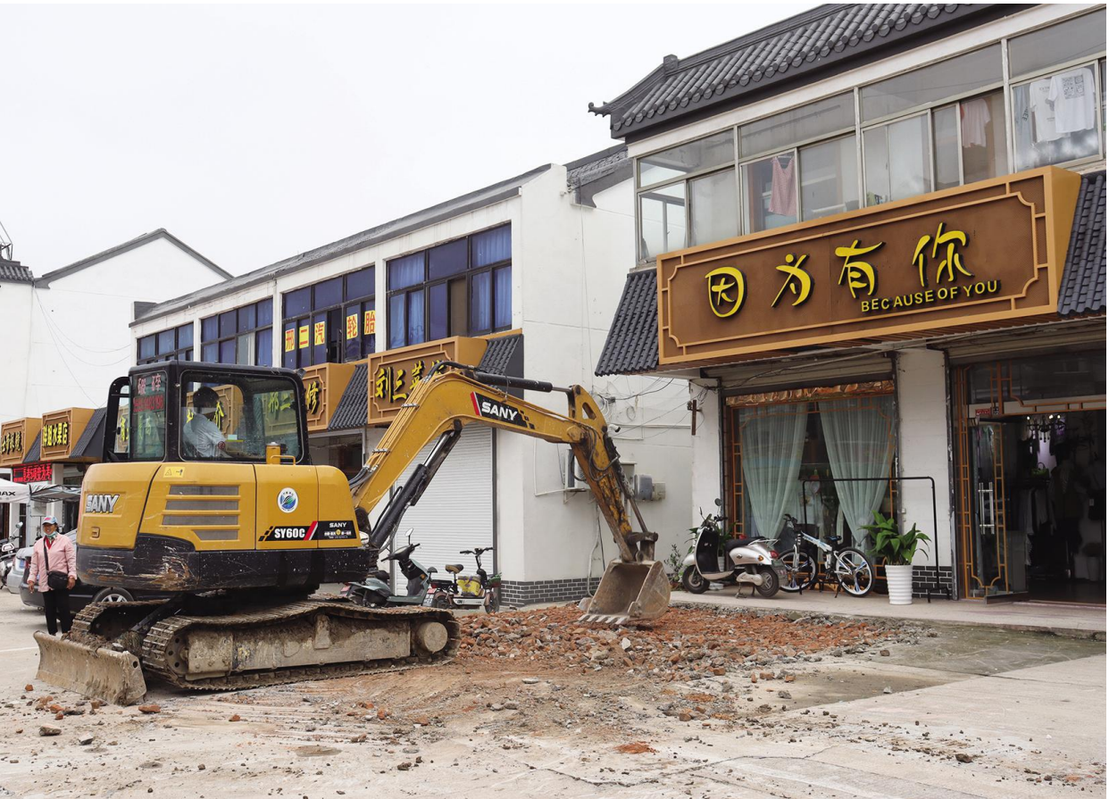
近年来,黄沙港镇依托地处沿海的区位优势 and 拥有国家中心渔港资源优势,找准发展定位,完善提升规划,高效务实推进,倾力打造国际化旅游型特色小镇。图为该镇海堤路立面提升工程正在施工。 王荣 摄
