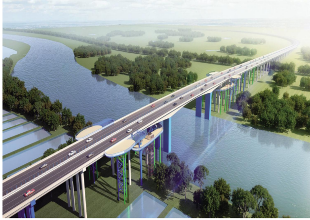
环海湿地旅游区湿地观光大桥
