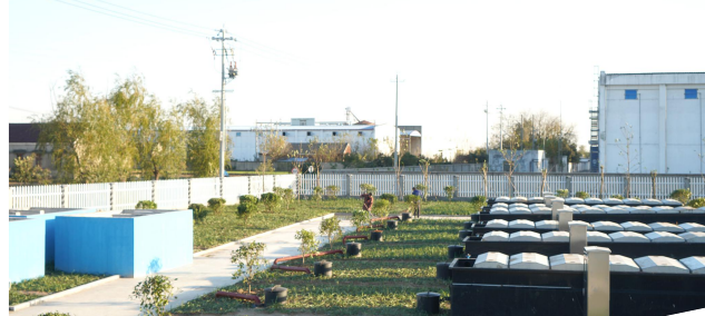
提升改造后的洋马污水处理厂
