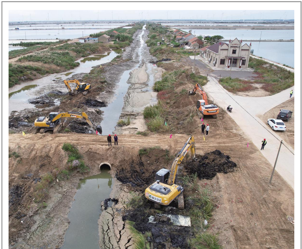
为推进渔业绿色高质量发展,近年来,射阳盐场以创建“国家渔业示范园区”为契机,全力推进重大项目建设。当前,总投资近4000万元,正在建设的7800亩集中连片内陆养殖池塘标准化改造和尾水治理项目,将通过生态化改造项目的实施改善养殖区域内水体生态环境,使池塘外排尾水得以净化处理达标排放,助推水产养殖经济高质量发展。图为如火如荼的施工场景。
