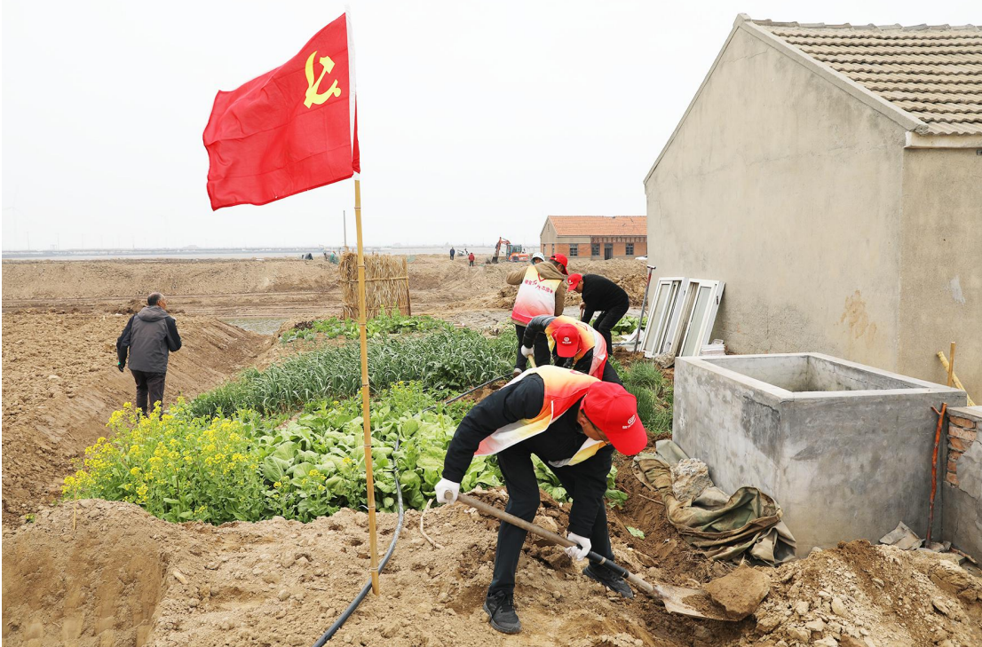
为切实解决部分边远养殖户生活用水困难,让他们早日喝上“放心水”,3月20日,射阳盐场达阳管理区党支部以党日活动为契机,结合当前开展的“我为群众办实事”活动,积极组织党员志愿者投入自来水管改造、改造工作中,图为志愿者们挖管道的场景。
