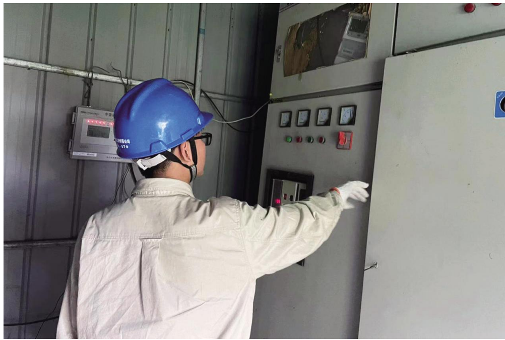
5月18日,兴桥镇敬老院邀请供电公司工作人员上门为敬老院检查配电路和设备,排查用电安全隐患,保障敬老院的安全用电。图为工作人员仔细检查了敬老院房屋照明线路、插座、制冷等用电设备安全,对排查的隐患现场消除、整改。 冯君 摄
