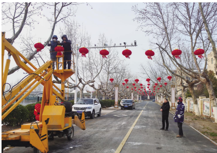
春节临近,在淮海农场公司中心地带的创业路上,施工人员正抓紧时间悬挂大红灯笼、布置景观,营造浓浓的年味。 陆军 摄
