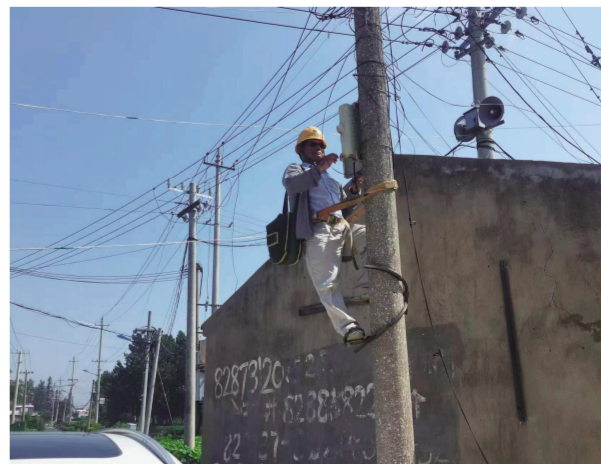
为保障社区企业职工和居民收看巴黎奥运会,江苏有线射阳分公司外勤人员深入企业和社区,排除有线电视故障。图为抢修有线电视线路现场。
