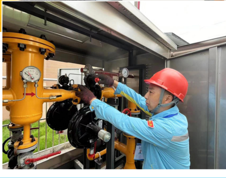
随着天气逐渐寒冷,能源保供进入迎峰度冬关键期,射阳中石油昆仑燃气有限公司组织人员开展设施巡检,消除安全隐患,筑牢燃气安全防线,保障用气安全。 盛斌 龚萌萌 摄
