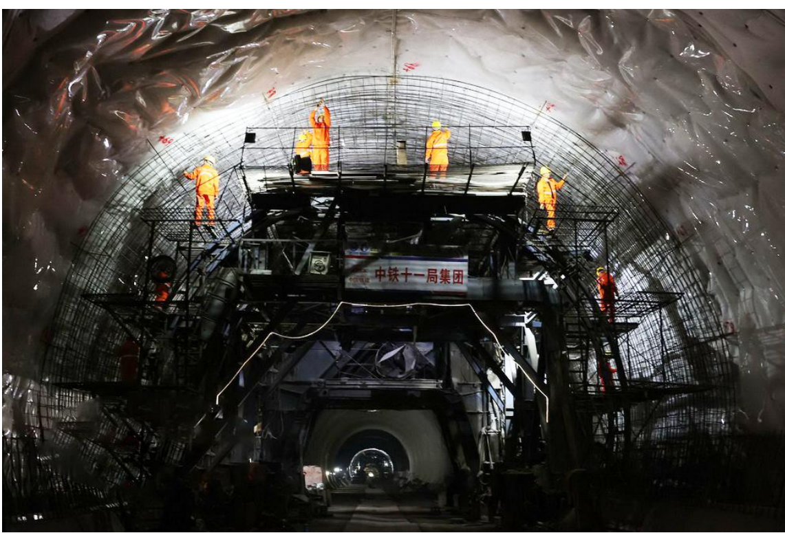
4月12日, 由中铁十一局承建的郑万高铁高架坪隧道顺利贯通。该隧道位于湖北省南漳县境内, 全长5506米, 工程地质复杂, 施工难度大, 安全风险高, 为郑万高铁重难点控制性工程。郑万高铁全长818公里, 设计时速350公里, 起于郑州南站, 经过湖北、重庆, 终到万州北站, 是我国“八纵八横”高铁网中京昆通道的重要组成部分。郑万高铁全程桥隧比高达90%以上, 被誉为世界高铁领域难度最大、风险最高的铁路。
