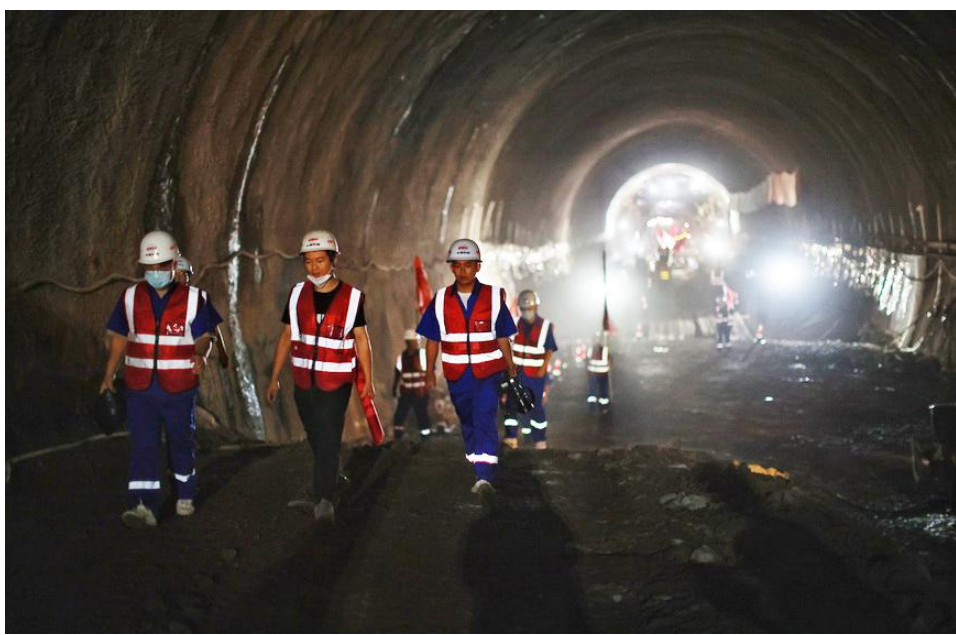
6月14日,由中铁十一局承建的贵南高铁那家寨隧道顺利贯通,该隧道地处贵州省独山县境内,全长1670米,隧道的顺利贯通为后续施工奠定了坚实基础。贵南高铁设计时速350公里,是我国“八纵八横”高速铁路主通道包头至海口通道的重要组成部分。
