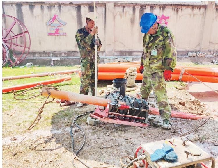
本报讯 (记者 钱青)7月14日上午6时,福溪1号公变低压大修项目启明工班的施工人员便来到现场,系上安全带,戴上手套、安全帽,开始一天的忙碌工作:将易出故障的旧线拆除,以线芯面积120平方毫米的新线替换。
