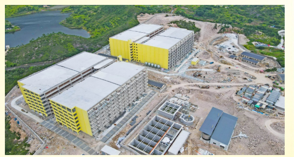
华统生猪养殖项目完成主体建设
