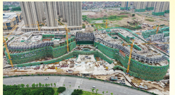
始丰溪文化休闲项目完成主体工程
