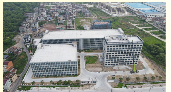
万胜一期、二期完成主体工程
