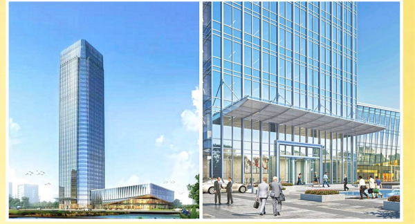
总部经济大楼开工建设
