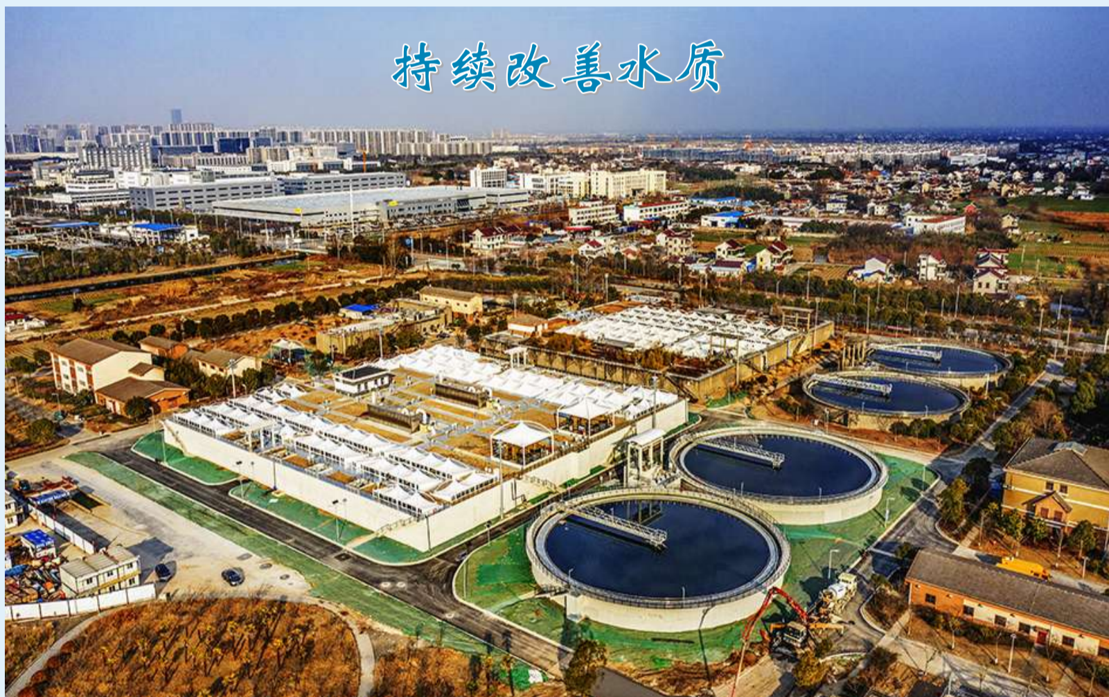
区益民水处理有限公司二期扩容提升改造项目主体完工，目前已进入试运行阶段。二期项目完成后，公司的日处理规模将由4.8万吨扩容至9.6万吨，处理后的出水水质仍将全面执行《城镇污水处理厂污染物标准》一级A标准，服务范围将延伸覆盖通州城区、南通高新区、二甲镇、西亭镇、兴东街道、川姜镇等地。 牟卓敏 摄
