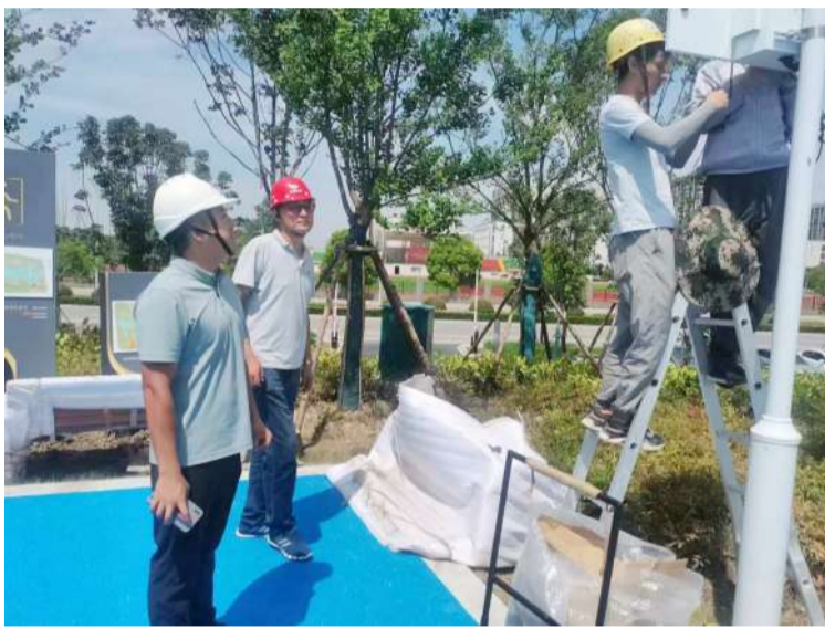
李荣在金乐公园工地现场检查设备安装进度。
