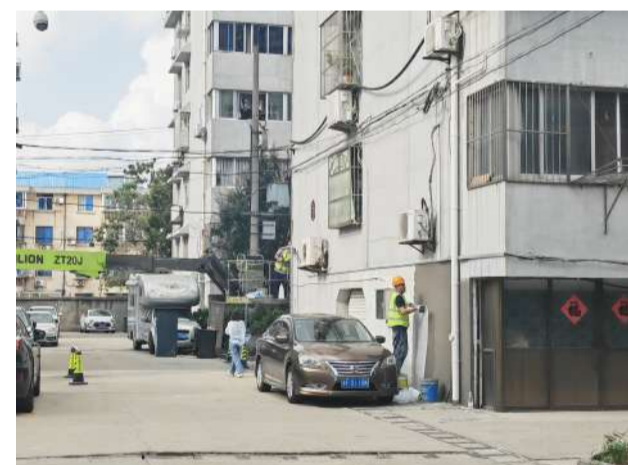
图为工人们正在新怡花苑进行外墙翻新。钱吴蝶 摄
