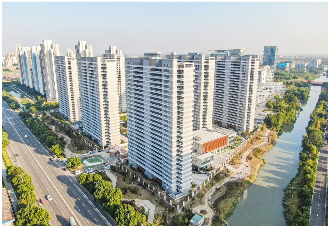
常州科教城“金凤凰”人才公寓将于下月交付使用。该人才公寓占地67亩,总建筑面积150630平方米,由8栋高品质公寓和1栋建筑面积3400平方米的人才共享中心组成,共有房源1683套,并设有秋白书苑、众创空间、共享健身房等公共服务配套设施。图为该人才公寓航拍。 高岷 陆新 徐晶玮摄
