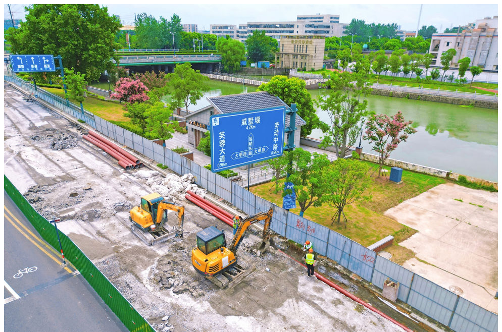
炎炎夏日,在位于常州经开区的延陵东路提升改造工程施工现场,筑路工人们挥汗如雨,保质保量赶进度。据悉,该工程全长7.7公里,分为丁堰段和戚墅堰段,包含道路、排水、设施、景观绿化等,预计今年10月底全线通车。图为丁堰段施工现场。徐芊卉 摄
