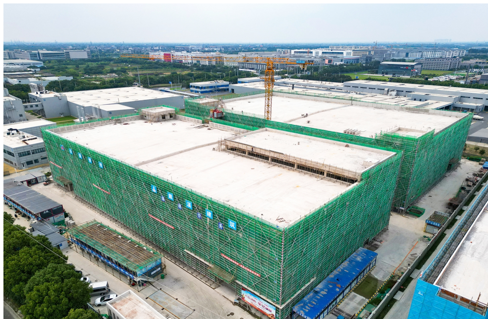
市重大项目——瞻驰高端光学蒸镀材料和功能粉体材料项目位于常州西太湖科技产业园,目前已完成主体封顶,计划新建生产车间及配套设施约3.6万平方米,力争明年建成投产。达产后将具备年产150吨蒸镀材料、2000吨功能粉体材料的生产能力。 陆新 徐芊卉 摄
