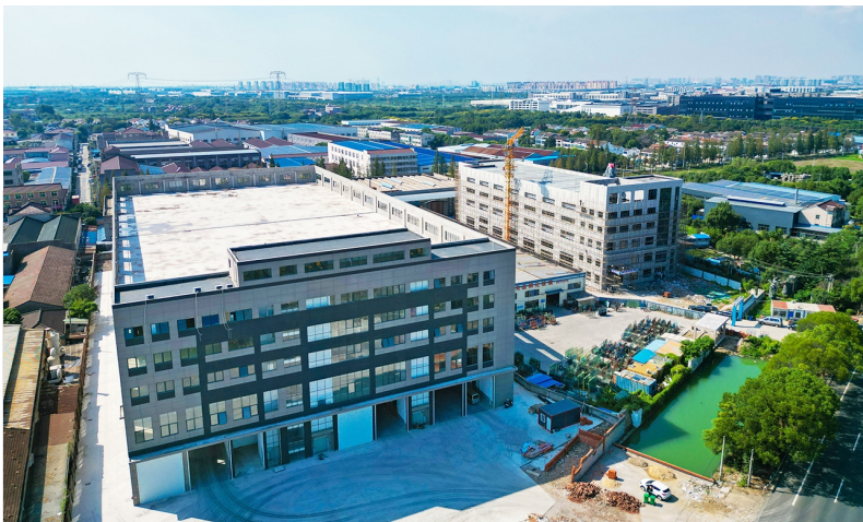
位于前黄镇的区重点项目——常州亮晶钢化玻璃有限公司年产10万台智能医疗床项目,总投资6000万元,占地约8800平方米,规划建设1.2万平方米厂房。目前已完成主体建设,预计12月竣工。 陆新 徐芊卉 摄
