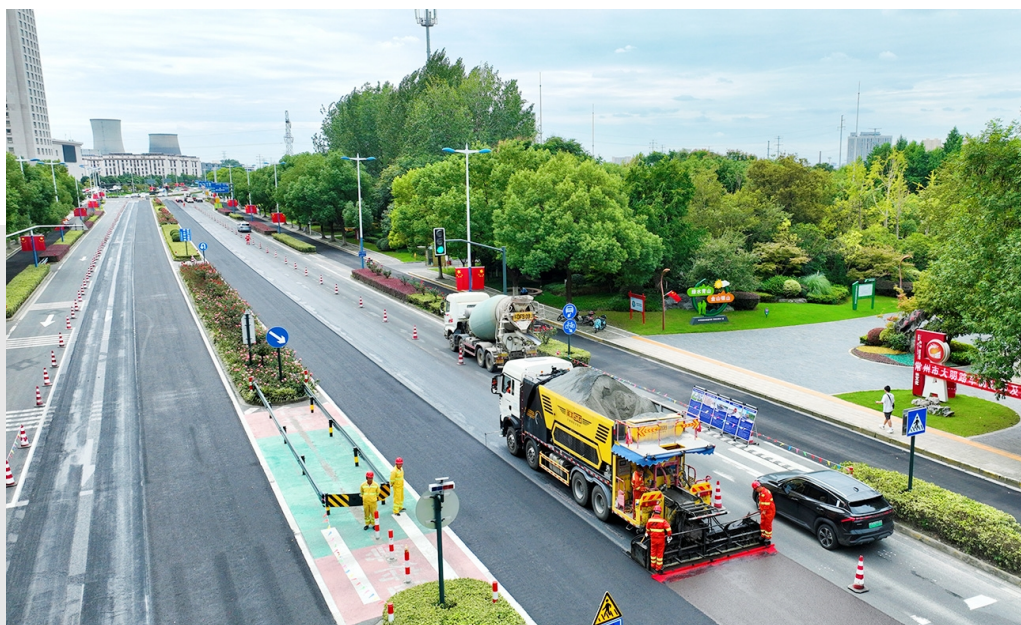
常州经开区建设管理服务中心采用复合有机水硬性材料和加粘磨耗层施工技术对大明路（龙城大道至东方东路段）进行预防性养护。相较传统养护作业，此次应用的新技术造价仅需三分之一，绿色环保、操作便捷，大大提升了养护效率，也为常州经开区道路迈入“预养护时代”打开了新思路。图为大明路养护施工现场。
