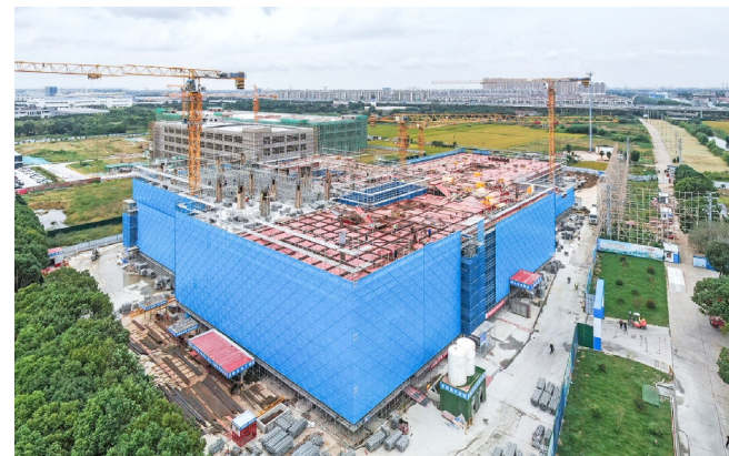
市重大项目常州医药产业创新中心项目位于常州西太湖科技产业园，总投资16亿元，建筑面积27万平方米。其中，一期项目占地面积36.76亩，主要建设医疗健康产业研发办公楼、商业、餐饮配套用房、机动车库等。目前，一期项目正在加快建设，预计年内完成主体封顶。徐晶玮 摄
