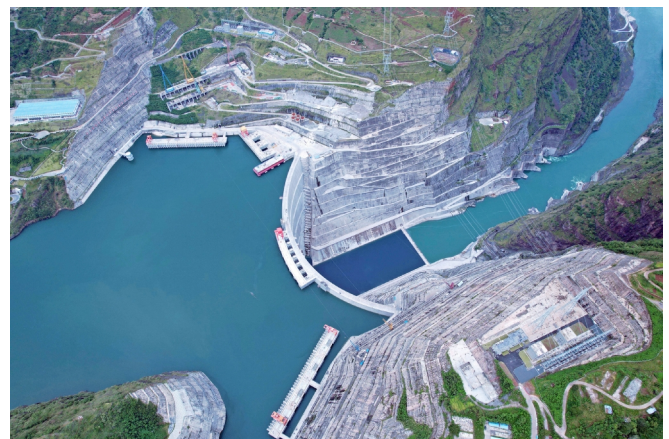
10月12日,金沙江白鹤滩水电站累计发电量突破1000亿千瓦时,相当于节约标准煤约3007万吨,减排二氧化碳约8240万吨,源源不断的清洁电能输送至江苏、浙江等地,保障长三角地区经济发展和民生用电需求。白鹤滩水电站位于四川省凉山彝族自治州宁南县和云南省昭通市巧家县境内,是我国实施“西电东送”的国家重大工程。图为12日拍摄的白鹤滩水电站。 新华社发
