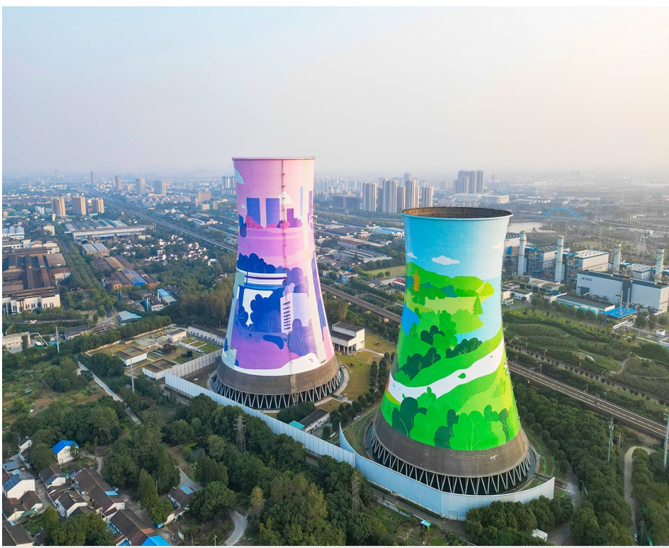
近日，为了让老地标展现新面貌、焕发新生机，位于常州经开区的江苏华电威垦发电有限公司对3座冷却塔开展了外壁彩绘美化和灯光亮化施工。目前，两座冷却塔的美化工程已完工，另一座正在计划施工中。图为冷却塔航拍图。
