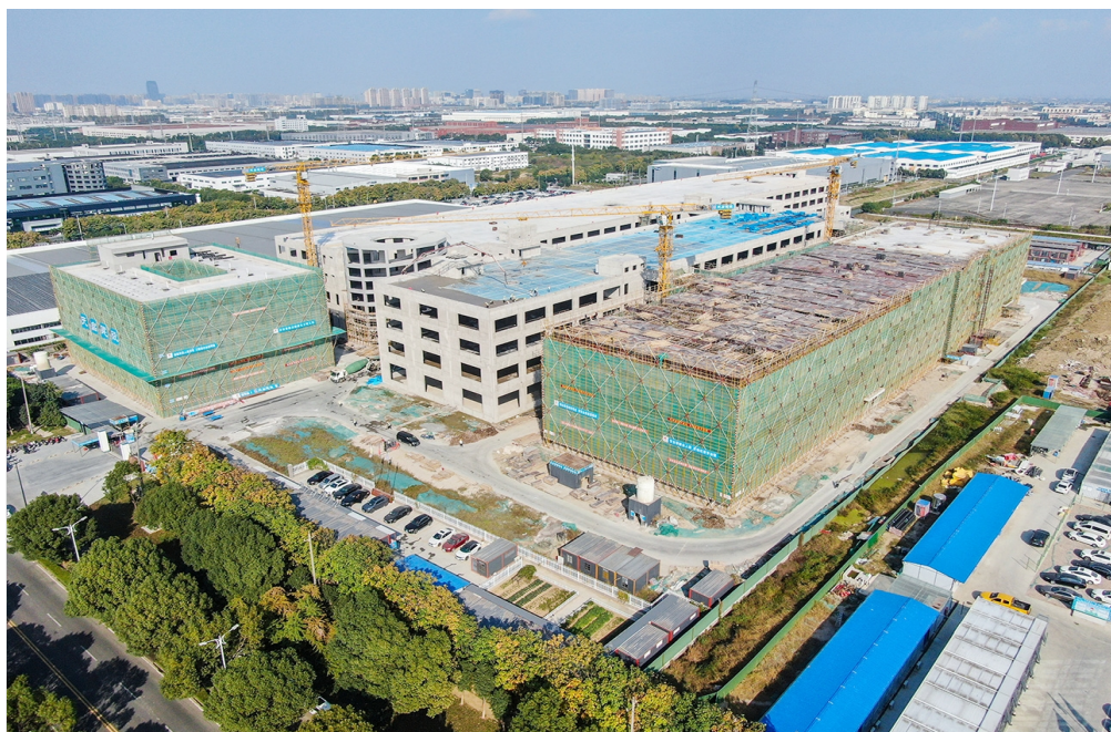
眼下,位于武进国家高新区的市重大项目——万帮数字能源智能充电设备项目正在加快主体施工,预计明年4月竣工。项目占地94.36亩,新建生产厂房及附属设施总建筑面积11.3万平方米,建成后 will 形成年产交直流充电桩、双向直流充电桩及能源路由器约200万台的生产能力。徐晶玮 摄
