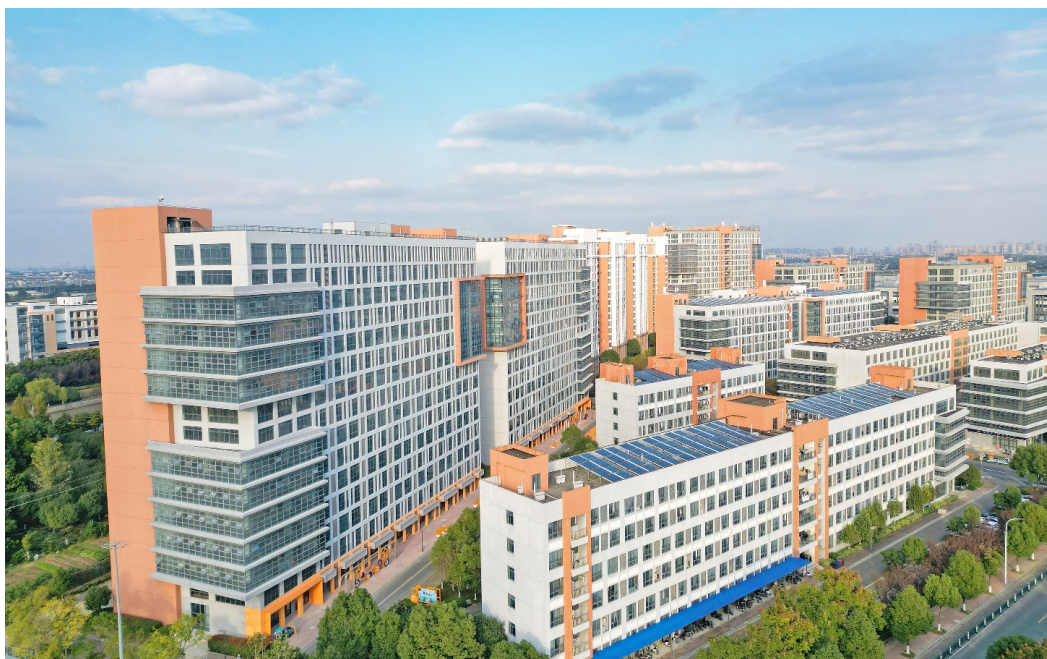
位于西太湖科技产业园的翊望青年社区,占地面积128.8亩,由伟驰集团开发建设,现有人才公寓4032套。今年以来,伟驰集团围绕“青年友好”主题,对社区户外休闲、运动健身等场所进行优化提升,为青年人才打造多点位、多样化、更舒适的社交共享空间。徐芊卉摄
