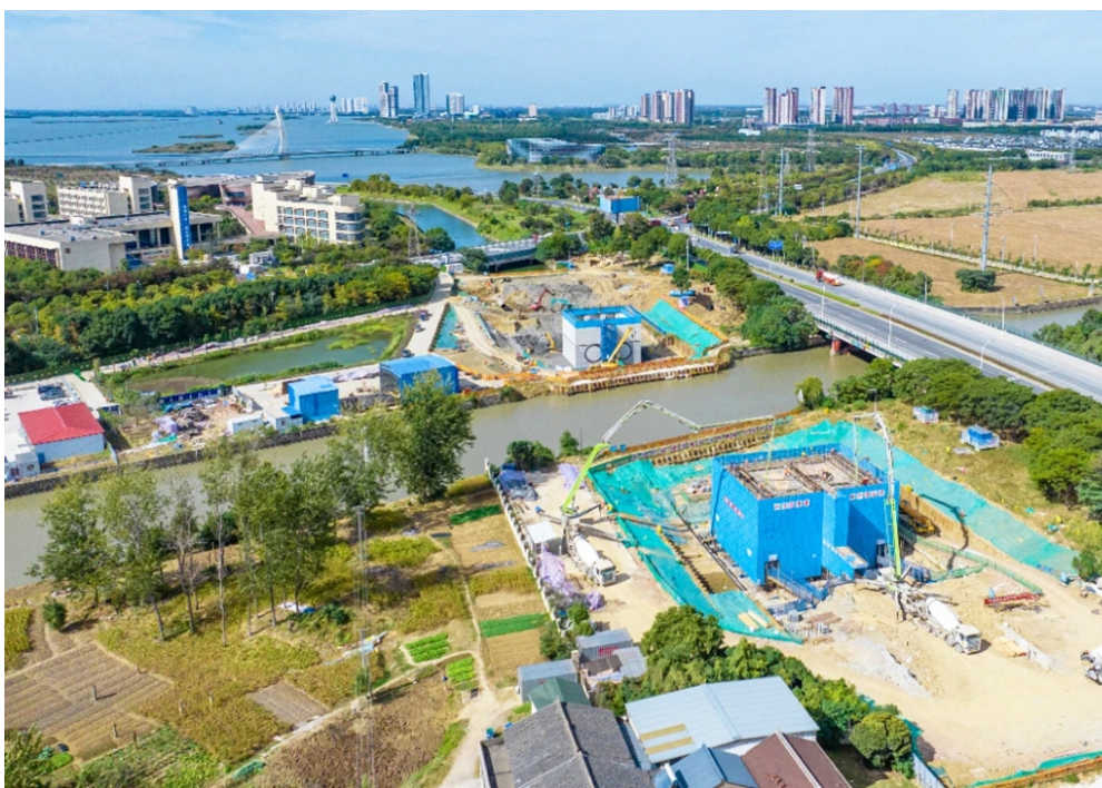
初冬时节，武南片区防洪除涝及物流活水闸站建筑物一期工程现场，机械马力全开，铲车穿梭、机声轰鸣，各环节井然有序推进。该工程主要建设4座防洪除涝和物流活水引排闸站建筑物，分别位于湖塘镇、牛塘镇、西湖街道和南夏墅街道，防洪标准为100年一遇，排涝标准为20年一遇，预计明年汛期来临前部分排涝功能投用。孙景昱 吴梦婷 摄
