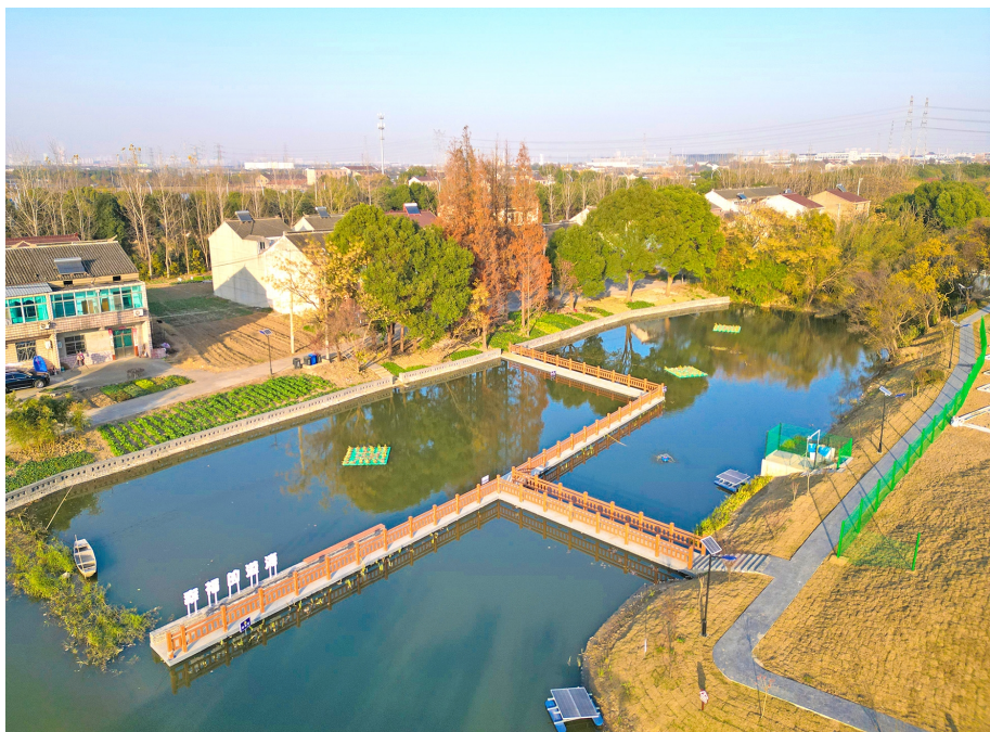
近日,位于礼嘉镇何墅村的塘家桥获评我区2023年度第二批幸福河道。近年来,何墅村投入250万元实施塘家桥整治提升工程,全力打造“水清、岸绿、景美”的良好生态,沿岸景观优美,亲水设施便民,乡村风貌得到了大幅提升。图为整治后的塘家桥浜。 徐芊卉 摄
