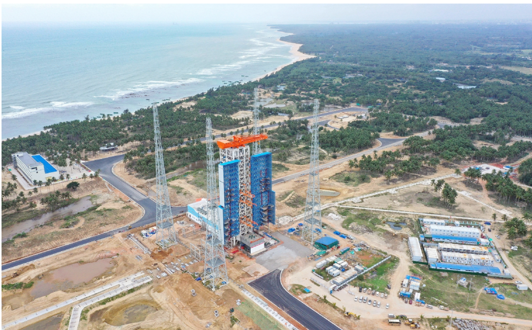
12月29日，位于海南省文昌市的海南国际商业航天发射中心一号发射工位正式竣工。该项目的建成，标志着我国首个商业航天发射场在形成发射能力过程中取得关键进展。图为海南国际商业航天发射中心一号发射工位。
