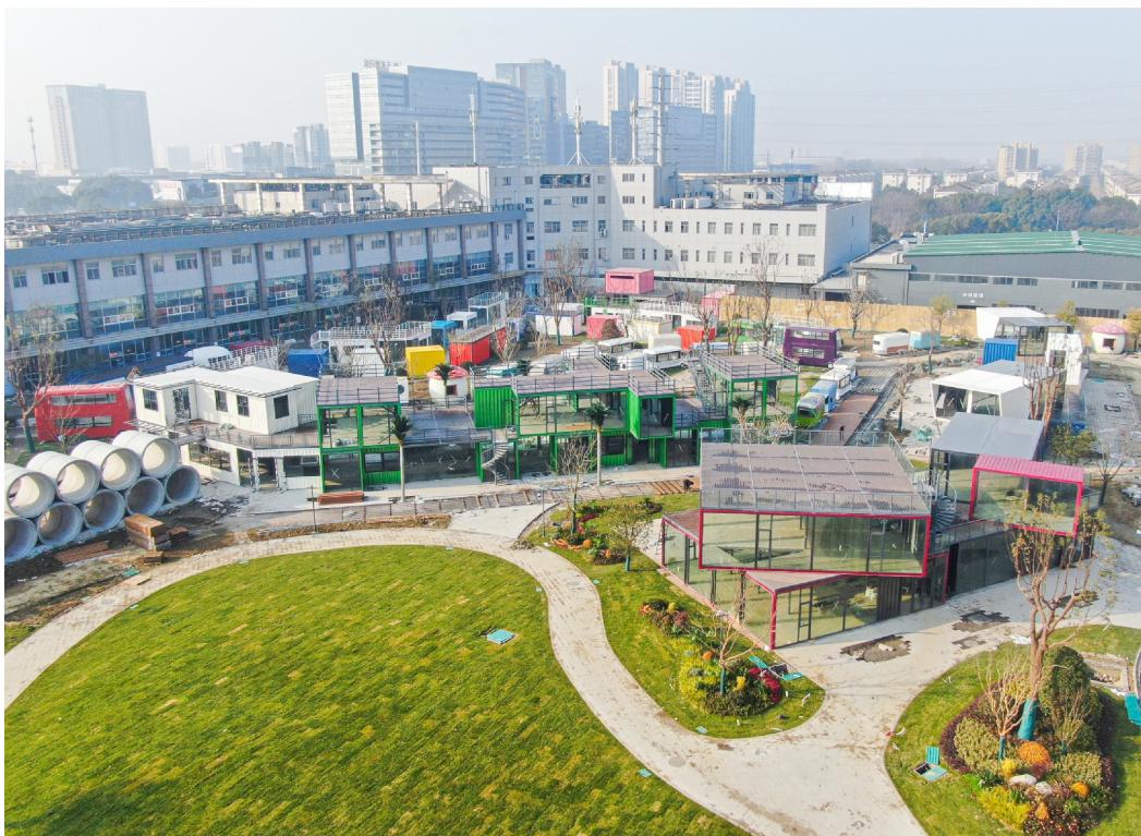
作为武进文旅精品项目之一的 T-PARK 蓝海豚文化艺术街区, 位于武南中路与常武中路交叉口, 由常运集团存量资产更新改造而来。该项目总占地面积约 8 万平方米, 定位 Z 世代青年网红潮集地, 集创意餐饮、文创市集、亲子文娱、城市营地等多功能业态为一体, 是我区首个文商旅沉浸式主题街区。目前, 该项目整体进度已完成 85% 左右。图为项目航拍。 陆新 徐晶玮摄
