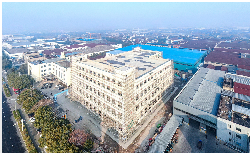
位于洛阳镇的联谊航空发动机管路部件项目是市重大项目,新增全自动三维数控弯管机、超声波清洗机、三坐标检测仪等设备162台(套),达产后将形成年产1500万套航空航天用合金管路零部件的生产能力,预计年产值4.15亿元。目前该项目厂房主体已竣工,进入内部装修阶段,预计今年11月竣工达产。徐晶玮 摄
