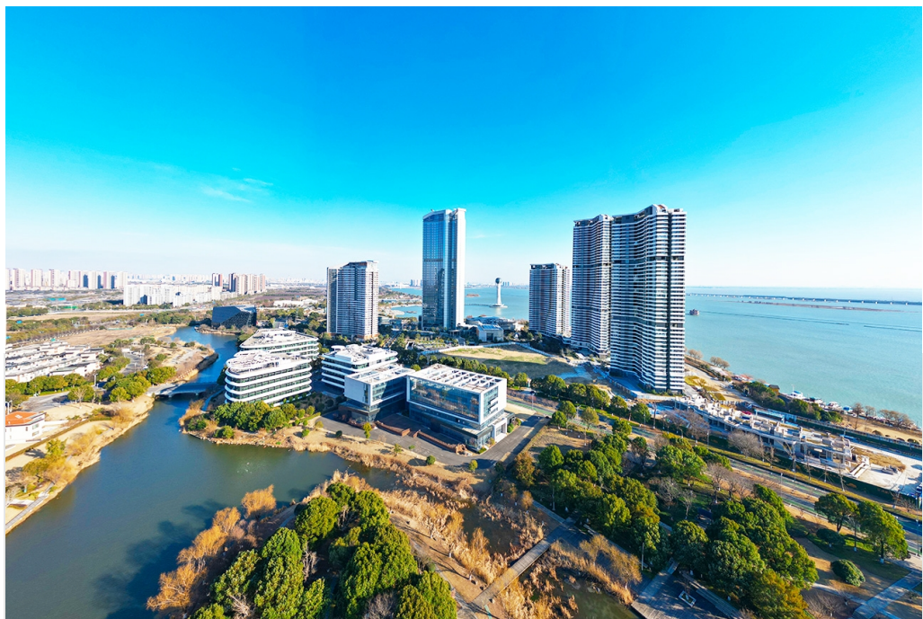
作为“两湖”创新区核心区,常州西太湖科技产业园风貌日新月异,生态、产业同步发展,城景一体、人水相依,展现了一幅壮丽的城市生态发展新画卷。图为园区一隅。徐芊卉 摄
