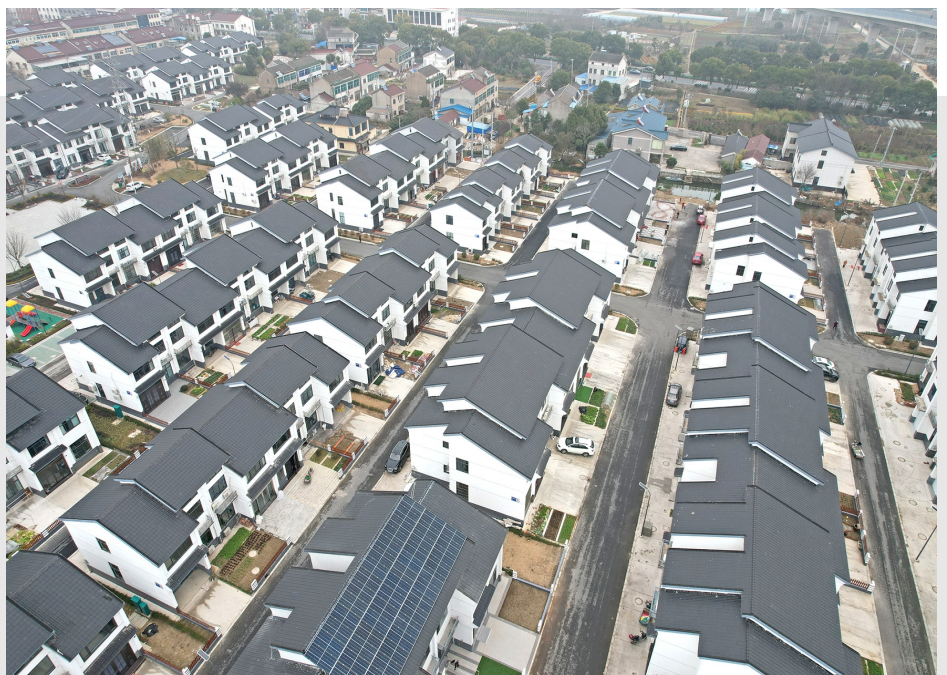
目前,位于嘉泽镇的成章自建区一期(北区)主体建筑已全部竣工,正在进行公建配套设施施工,预计 7 月完工。 潘梓柠 何新雨 摄
