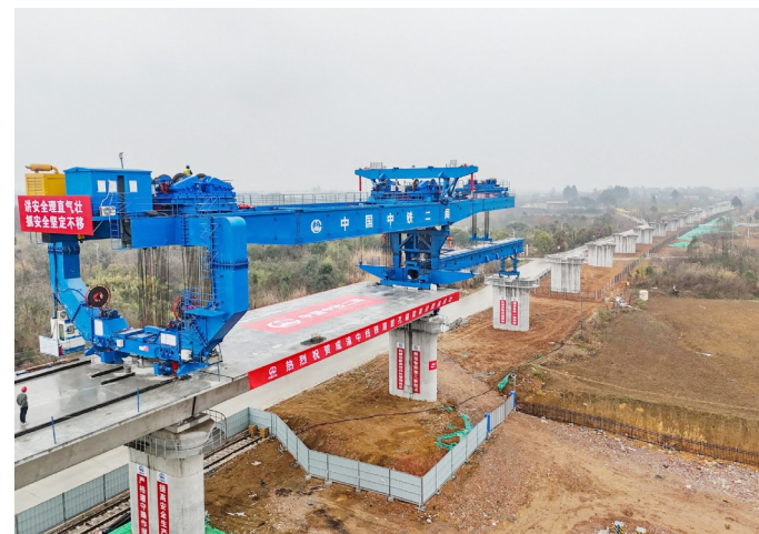
3月1日，首孔长32米、重约700吨的箱梁在成渝中线高铁龙泉特大桥成功架设，标志着成渝中线高铁箱梁架设施工正式启动。据了解，成渝中线高铁是我国“八纵八横”高铁网沿江通道的重要组成部分，正线全长292公里，设计时速350公里。新华社发
