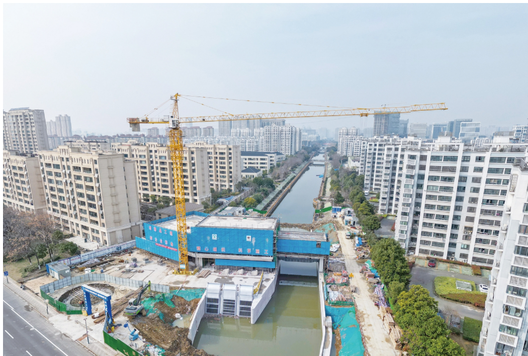
目前, 位于武南路大治桥北侧的湖塘河南枢纽已完成水工部分, 正在进行主厂房及管理房施工。据悉, 湖塘河南枢纽由单孔净宽 12 米节制闸和排涝 15 立方米 / 秒、引水 10 立方米 / 秒的双向泵站组成, 建成后将同步具备防洪除涝和畅流活水功能。图为建设现场。 陆新 徐晶玮摄
