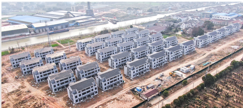
近年来,前黄镇不断加快农民自建房建设进度,高质量建设一批现代化宜居农房。目前,位于该镇的运河村自建区项目已进入尾声,总计建设94户楼房,外墙粉刷已完成,将于8月竣工交付。 陆新 徐晶玮 摄
