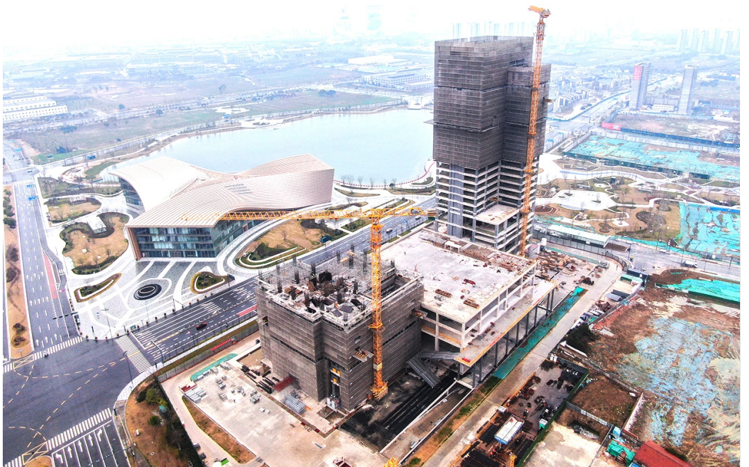
眼下,位于常州经开区东方新城中央商务区核心区的中天威斯汀酒店及商务办公双子楼项目正在加快建设,中天威斯汀酒店主体钢结构已顺利封顶。据悉,该项目由中天钢铁集团出资建设,总投资约12亿元,由一栋21层的国际豪华五星级大酒店、一栋23层的五星级甲级商务办公楼及宴会裙房组成,形成集整体楼宇经济、高端酒店及商务办公等功能于一体的商业中心。徐晶玮 摄
