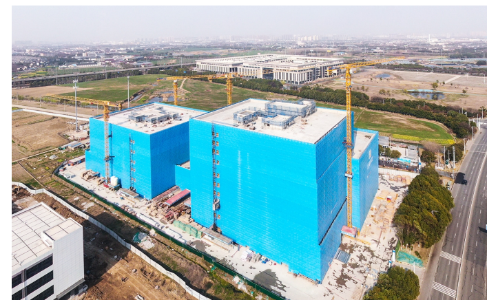
常州医药产业创新中心一期是市重大项目,位于常州西太湖科技产业园,目前总体进度已完成50%,二期项目即将开工,建成后将成为长三角医疗健康产业集聚地。图为项目一期航拍。徐晶玮 摄
